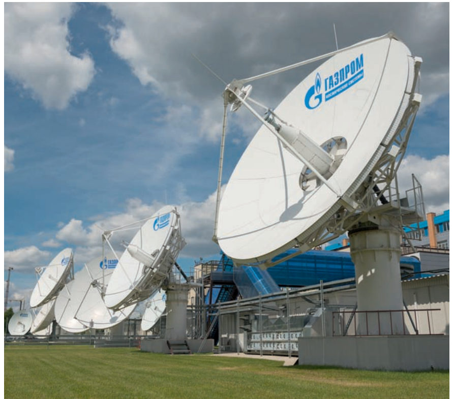
Телекоммуникационный центр Щелково (Московская область)
