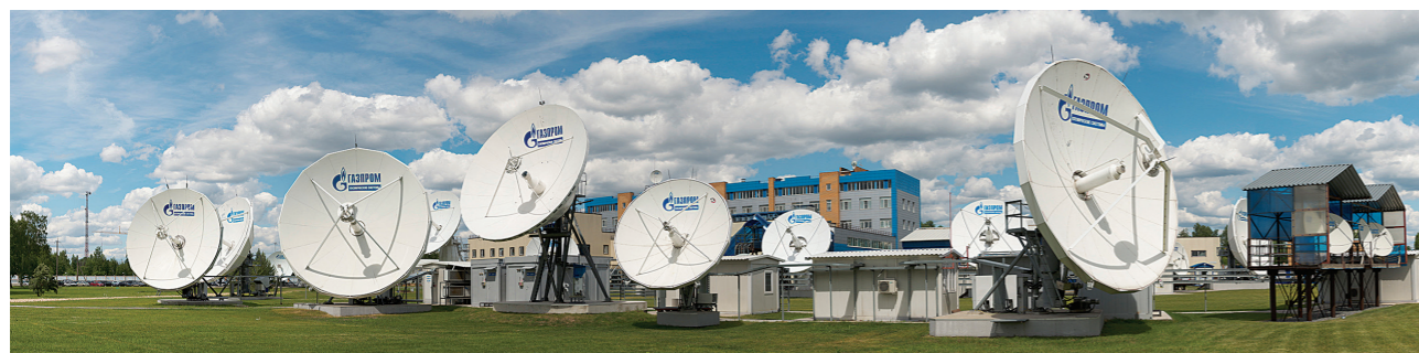
Спутниковый телекоммуникационный центр в г. Щелково
