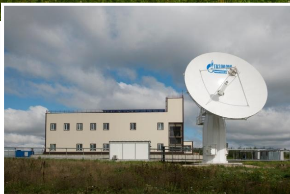
Резервный пункт управления (Переславль-Залесский)
