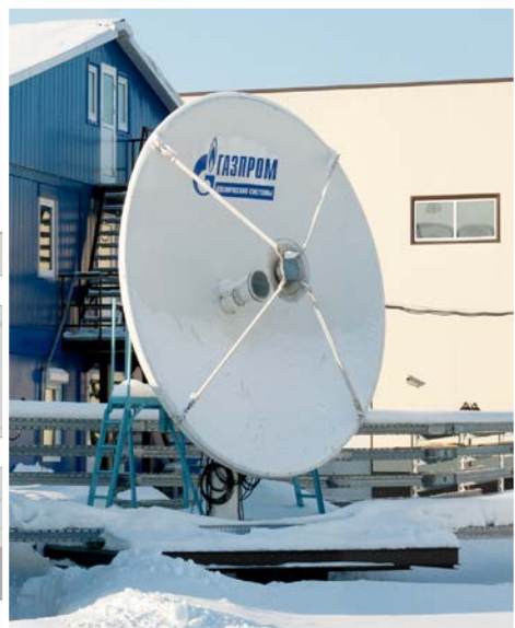
Диаметр антенны 2.4 – 5 м
