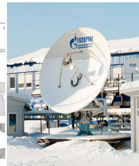
Диаметр антенны 2.4 – 5 м
