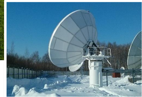
ВОСТОЧНЫЙ ПУНКТ УПРАВЛЕНИЯ (ХАБАРОВСК)
